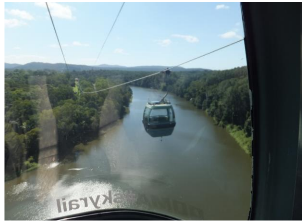
スカイレール
